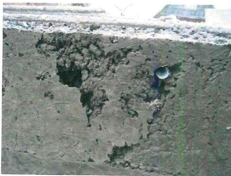
Рисунок 6.4 – Непровибрированные участки стены
