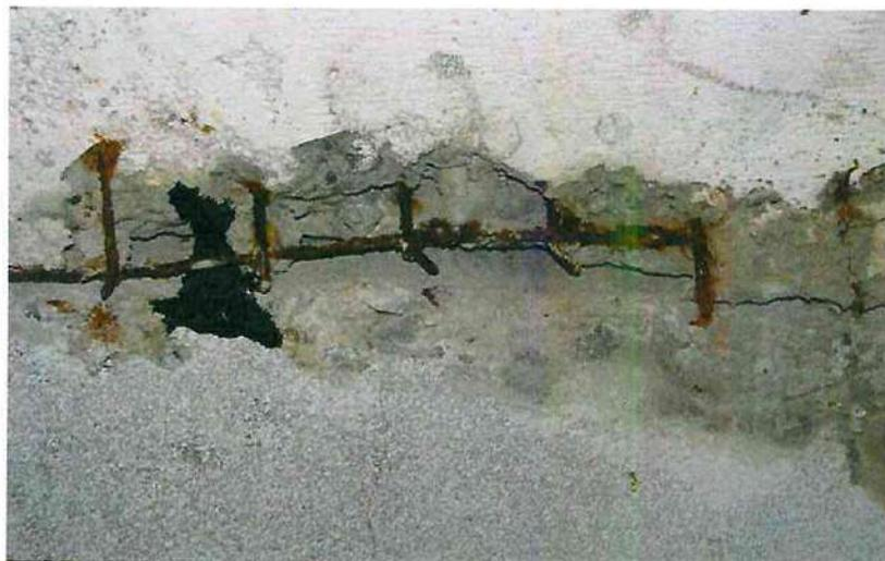
Рисунок 6.1 – Участок колонны с разрушением защитного слоя и оголением арматуры
