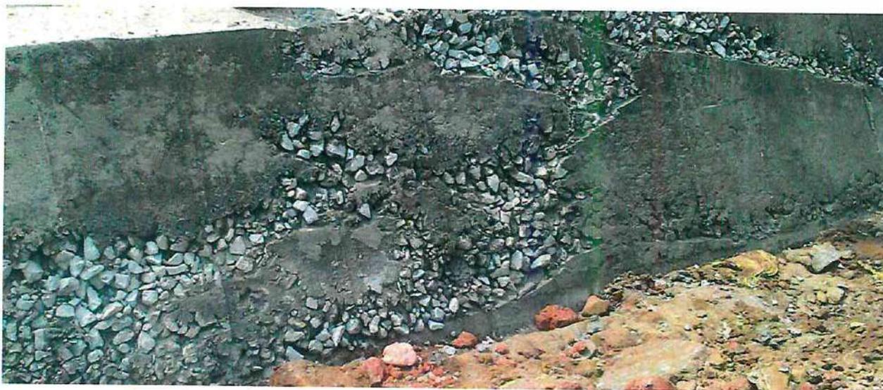
Рисунок 6.3 – Щебенистость на поверхности плиты и полости, незаполненные бетоном
