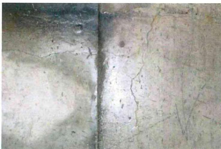
Рисунок 6.5 – Усадочные трещины на поверхности стены
