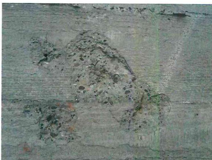
Рисунок 6.2 – Срыв защитного слоя бетона на участке стены, без обнажения арматуры
